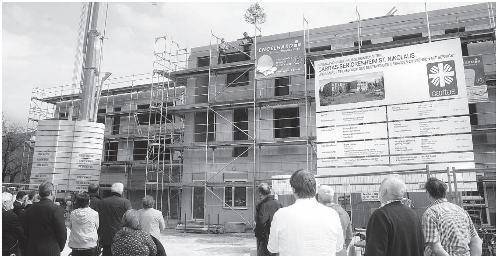
9,2 Millionen soll die Gesamtmaßnahme kosten. Im Neubau, an dem nun Richtfest gefeiert wurde, ziehen dann fünf Hausgemeinschaften ein. Der Altbau steht nach Umbau und Sanierung für „Wohnen mit Service“ zur Verfügung. Foto: Leykamm
